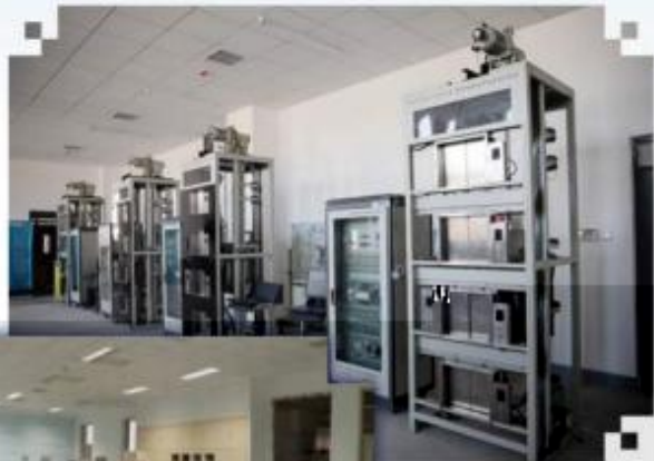
智能电梯安装调试维护训练场所
